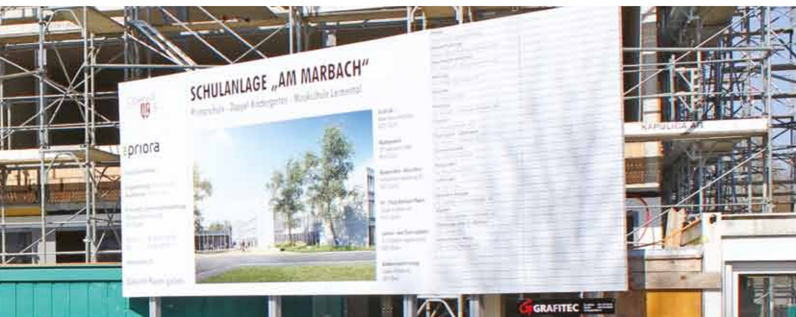
Seite 14/15: Baustelle der neuen Schulanlage Am Marbach.
