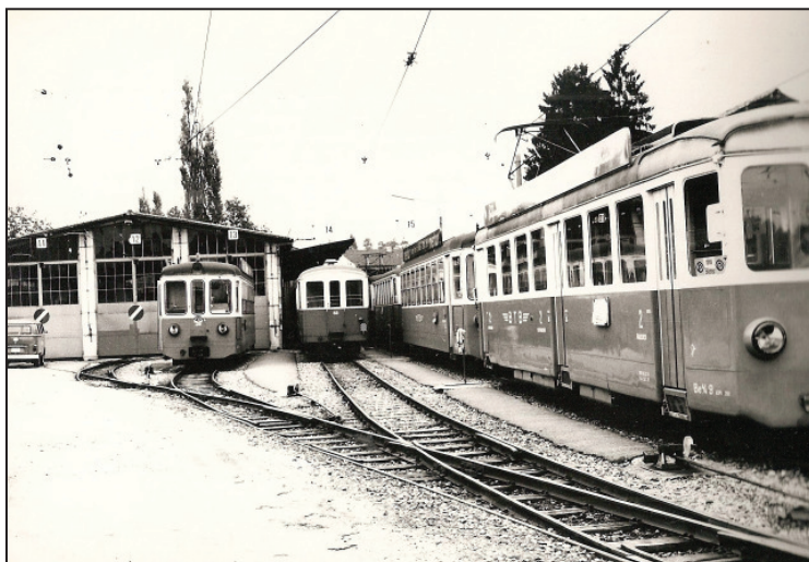
26 – Depot der Birsigtalbahn
