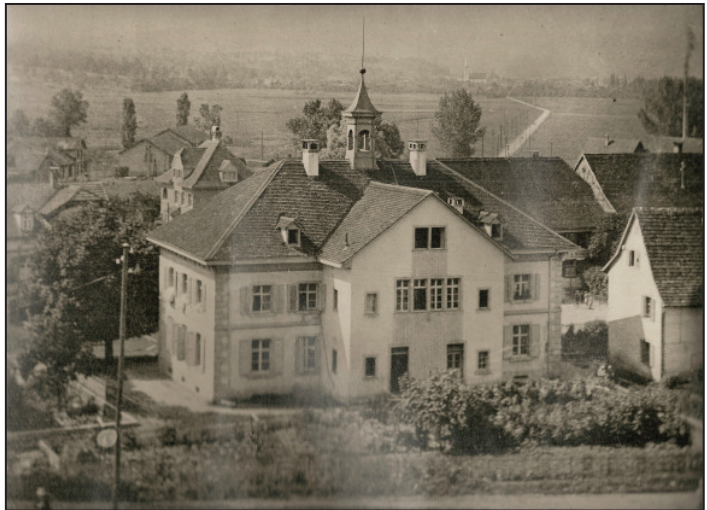
20 – Mittleres Schulhaus (vgl. Bild 6), Blick Richtung Therwil
