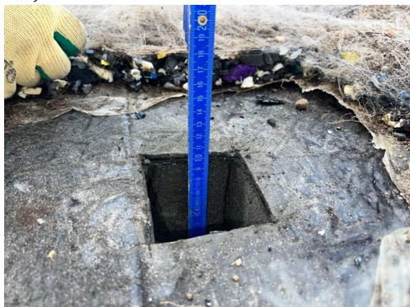
Sondageöffnung Flachdach Trakt 2
