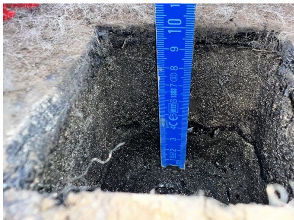
Sondageöffnung Flachdach Trakt 1
