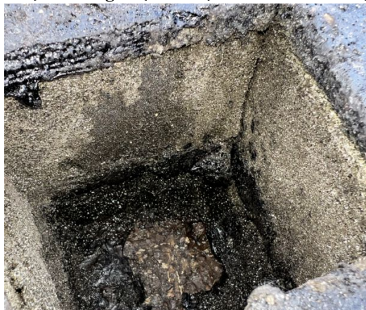
Sondageöffnung Flachdach Trakt 3
